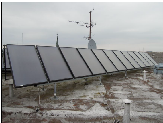
Obrázek 10 a 11: Nepřímotopné zásobníkové ohřivače; solární panely (2 x 12 panelů á 2,0 m 2 )
