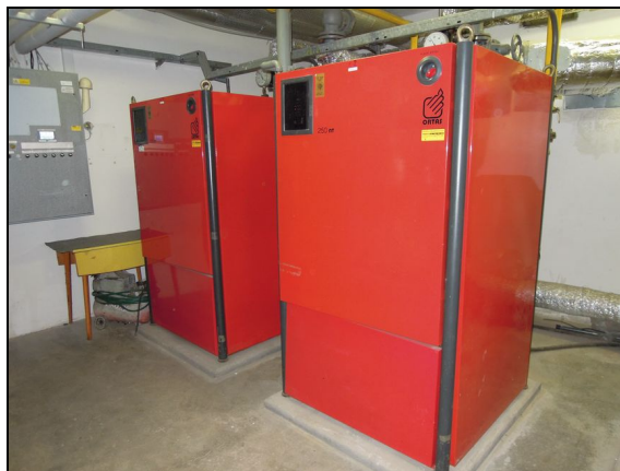
Obrázek 4 a 5: Zdroj tepla – kondenzační kotel Vaillant VKK 2006/3-E-HL a plynové kotle ORTAS 250 NT
