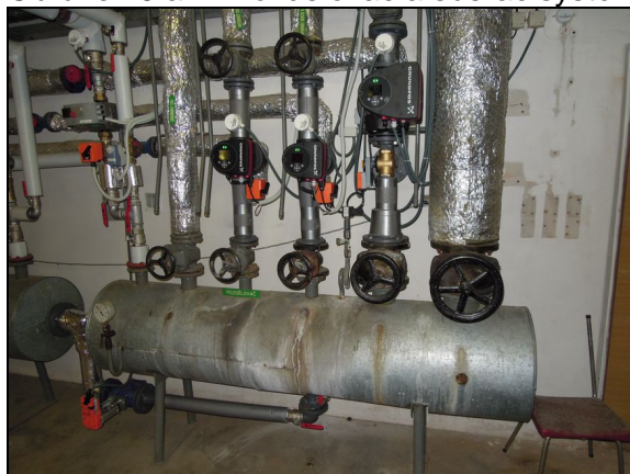
Obrázek 6 a 7: Rozdělovač a sběrač systému ÚT
