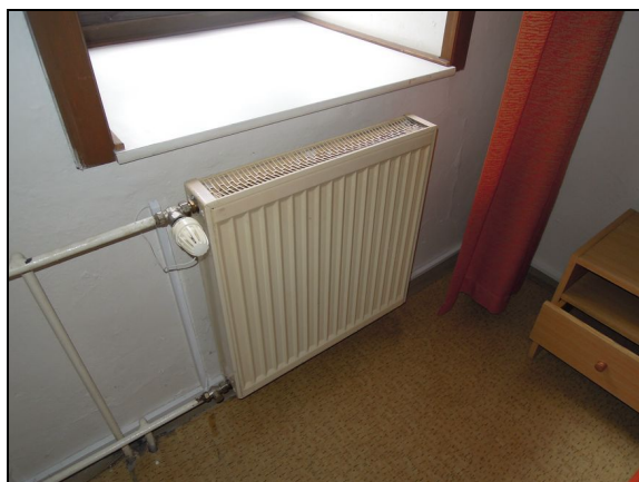
Obrázek 8 a 9: Otopné těleso; IRC termoregulační hlavice
